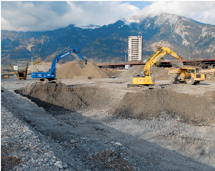
Eröffnung in einem Jahr: Auf dem 90 000 Quadratmeter grossen Areal beim Landquartener Bahnhof laufen die Bauarbeiten für das Alpenrhein Outlet Village auf Hochtouren.
