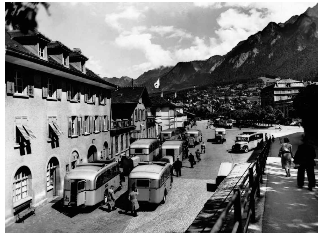
Von Hektik noch keine Spur: Blick auf die alte Postautostation am Bahnhof.
