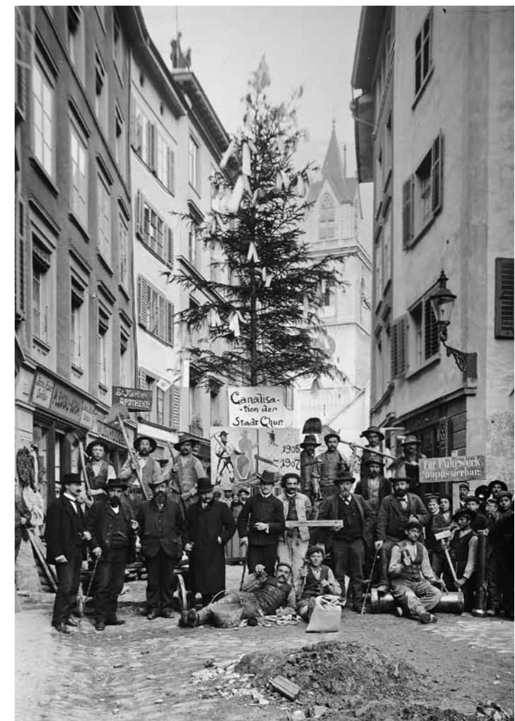
Ein Meilenstein in der Stadtgeschichte: Aufrichtefeier für die Kanalisation in der Oberen Gasse im Jahr 1907.
