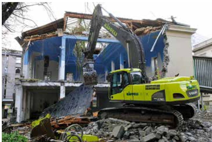
Zuerst wird abgebrochen: Der Sulserbau muss dem neuen Erweiterungsbau des Bündner Kunstmuseums Platz machen.
