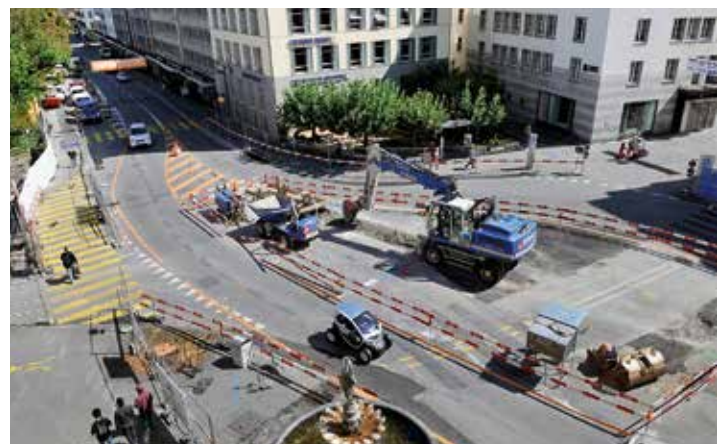
Unüberseh- und unüberhörbar: Seit Ende August sind die Bauarbeiten in der oberen Bahnhofstrasse und am Postplatz im Gang.
