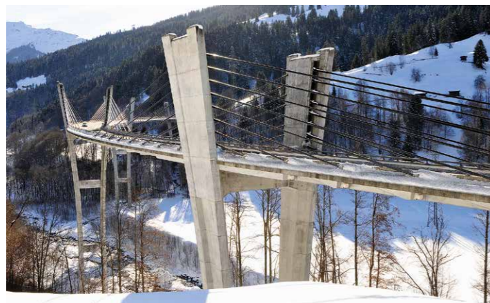
Ein Meisterstück der Ingenieur- und Architekturkunst: Die Sunnibergbrücke gehört zu den bekanntesten Brücken von Christian Menn.
