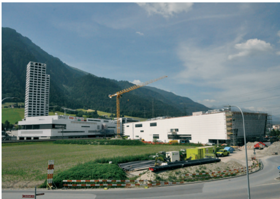
Der Bau schreitet voran: Das neue Blue Cinema wird im Herbst eröffnet.
