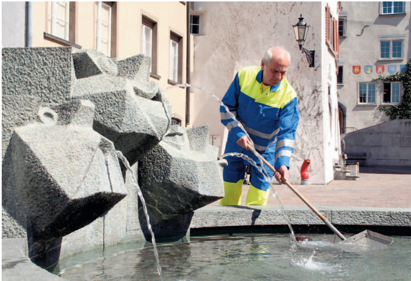
Roland Kürschner im Einsatz. Im Turnus von 14 Tagen werden sämtliche 125 öffentlichen Brunnen durch Angestellte der IBC gereinigt und überprüft.
