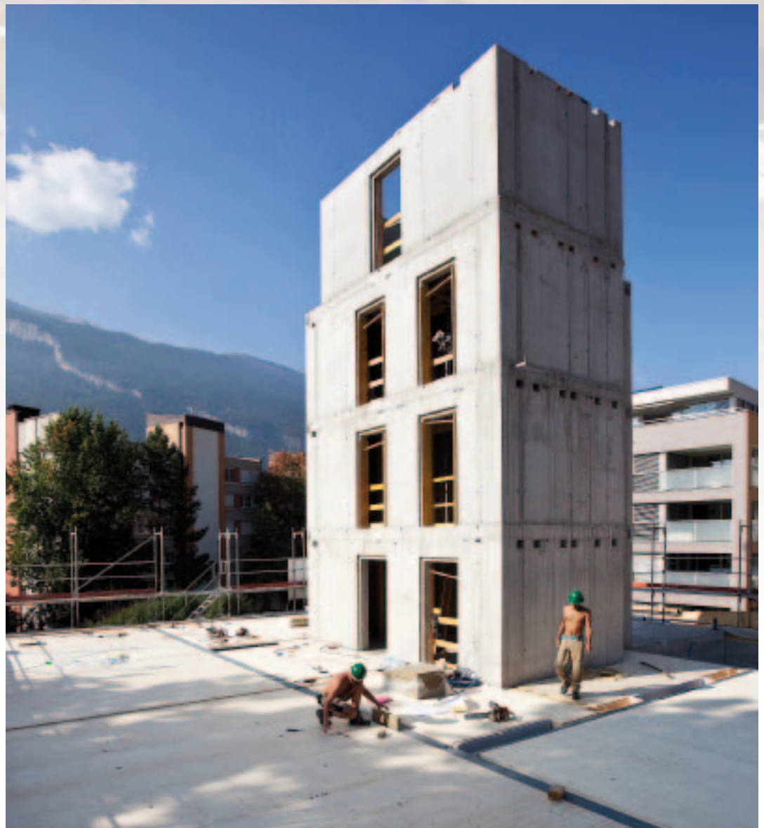
Stabil: Die Holzelemente werden um einen Kern aus Beton zusammengefügt.
