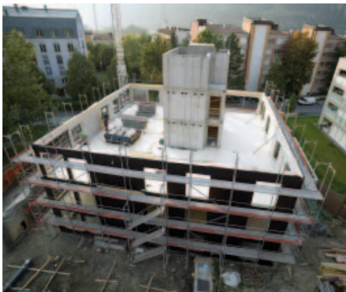
Im Eilzugtempo: In nur neun Tagen wurde der Holzbau aufgezogen.
