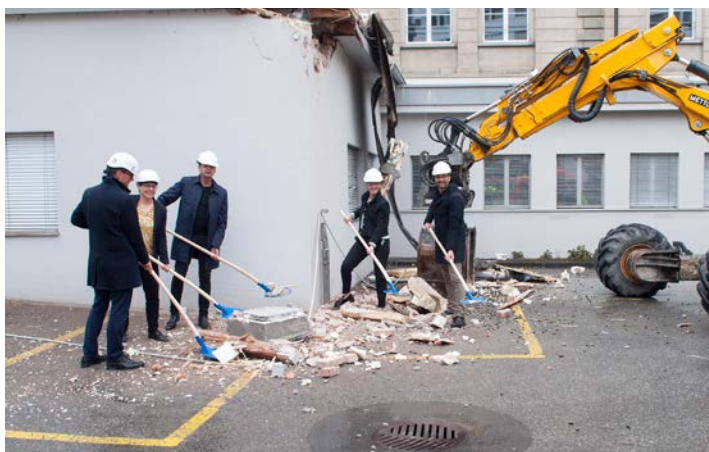
Spatenstich mit Regierungsrätin Carmelia Maissen (2. von rechts).
