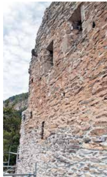
Die Aussenmauer der Burg ist bereits mit Mörtel instand gestellt.
