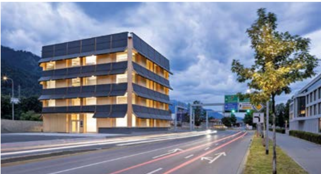
Das Netto-Null-Gebäude am Anschluss zur A13 überzeugt mit Nachhaltigkeit und Funktionalität. (Bild Ingo Rasp)
