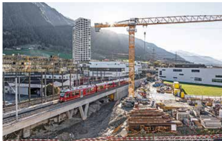
Die Bauarbeiten am Bahnhof Chur West schreiten plangemäss voran.
