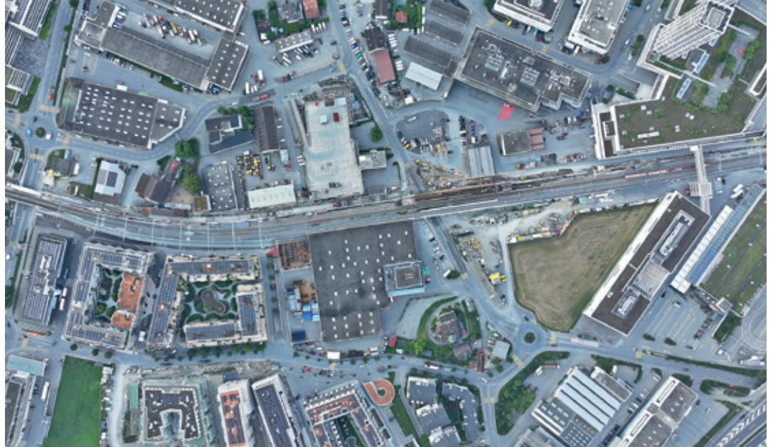
Drohnenaufnahme vom Bereich Raschärenstrasse mit Installationsplatz der rund 800 m langen Baustelle Bahnhof Chur West. (Bild zVg)
